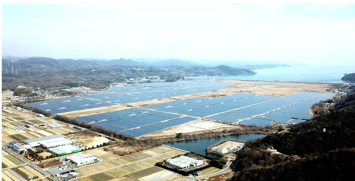
瀬戸内 Kirei 太陽光発電所(現在の様子)
