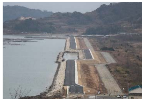
2017 年 3 月【安全安心事業】 瀬戸内市との施行協定に基づく防潮堤・防潮 扉新設工事及び堤防補強土木工事完了
