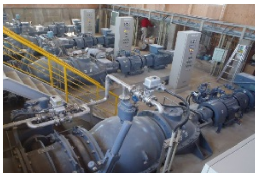
2016 年 3 月【安全安心事業】 瀬戸内市との施行協定に基づく予備排水ポン プ設置工事と非常用発電機新設 工事完了
