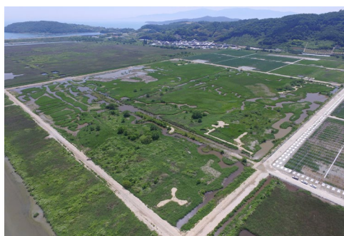
2016 年 1 月【環境保全事業】 自然保護エリア「錦海ハビタット」 創出工事完了
