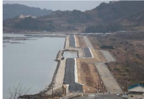
2017 年 3 月【安全安心事業】 瀬戸内市との施行協定に基づく防潮堤・防潮 扉新設工事及び堤防補強土木工事完了
