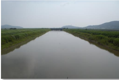
2015 年 5 月【安全安心事業】 瀬戸内市との施行協定に基づく錦海塩田 跡地内中央排水路整備工事完了
