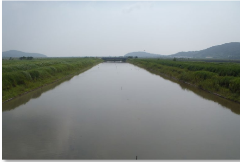
2015 年 5 月【安全安心事業】 瀬戸内市との施行協定に基づく錦海塩田 跡地内中央排水路整備工事完了
