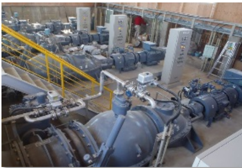
2016 年 3 月【安全安心事業】 瀬戸内市との施行協定に基づく予備排水ポン プ設置工事と非常用発電機新設 工事完了
