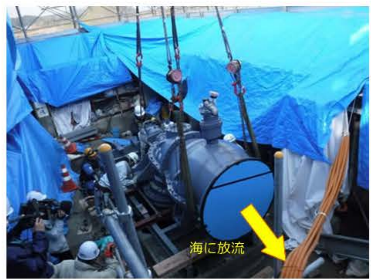
ポンプを増設している状況です
