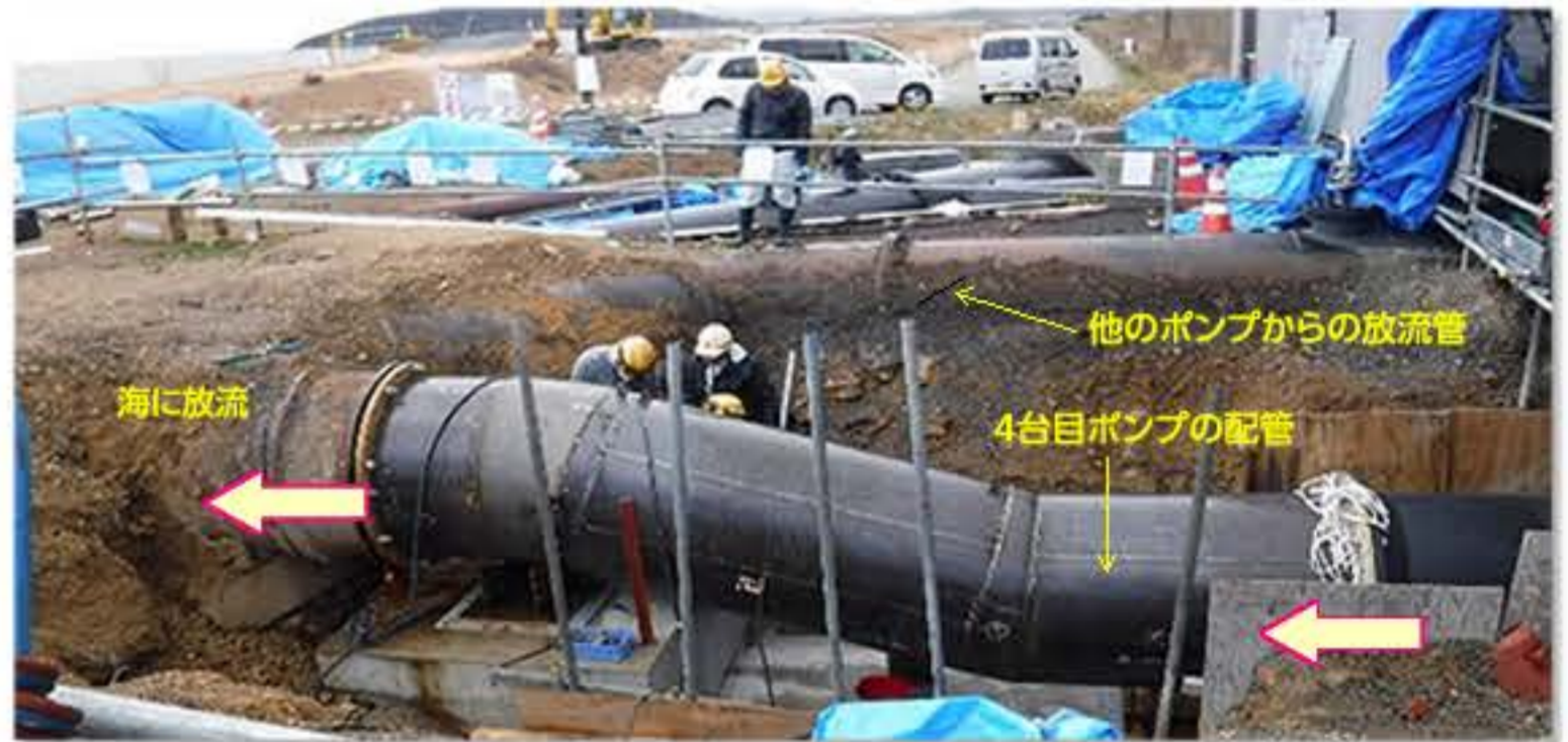
4台目のポンプからの配管を現在使用している放流管に接続する準備をしています。
