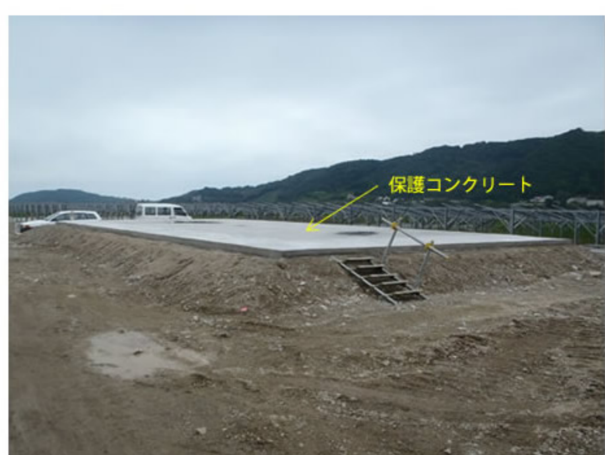
⑥ EPSブロックの保護コンクリートを打ちます
