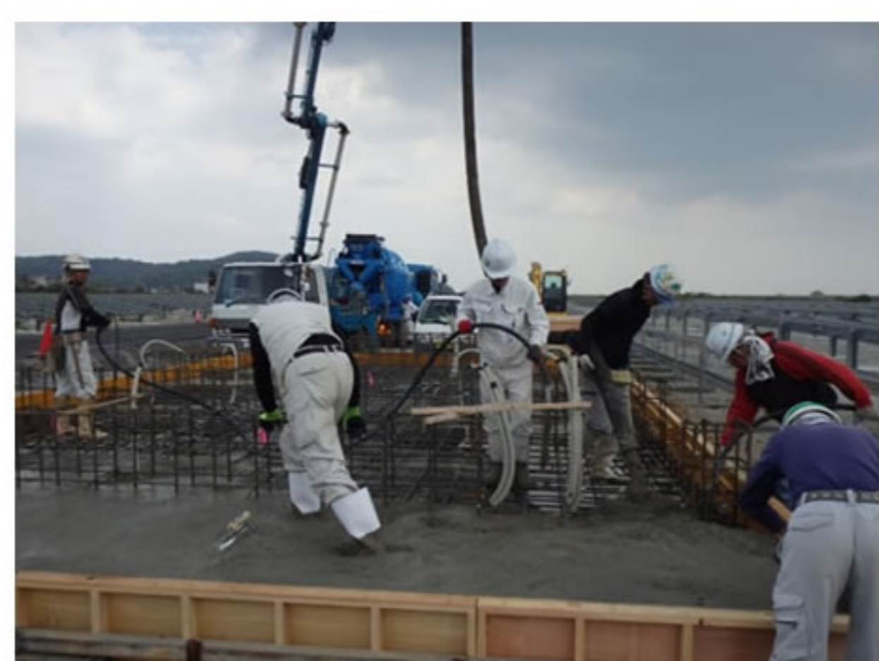
⑨ 型枠の中にコンクリートを打ち込みます
