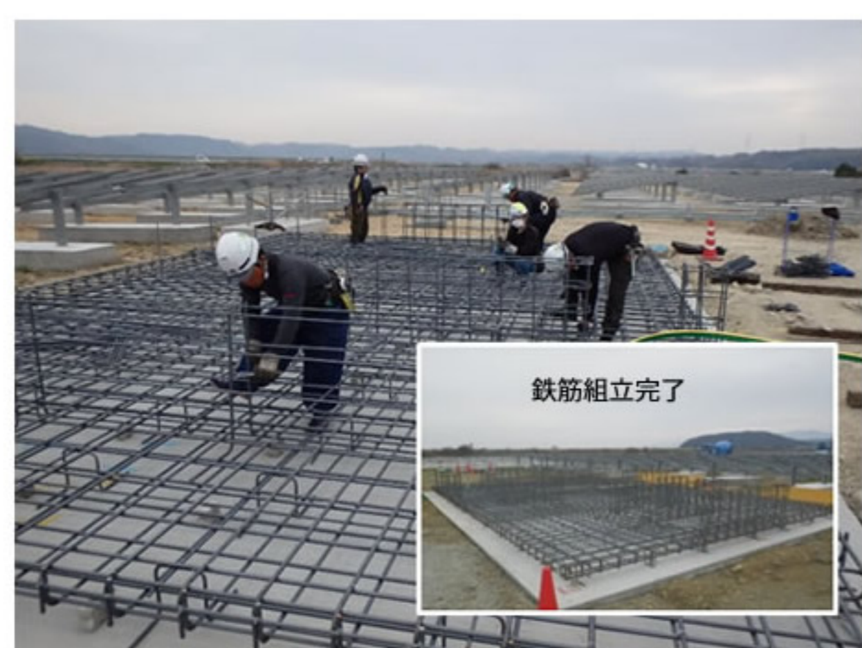
⑦ 保護コンクリートの上に鉄筋を組立てます
