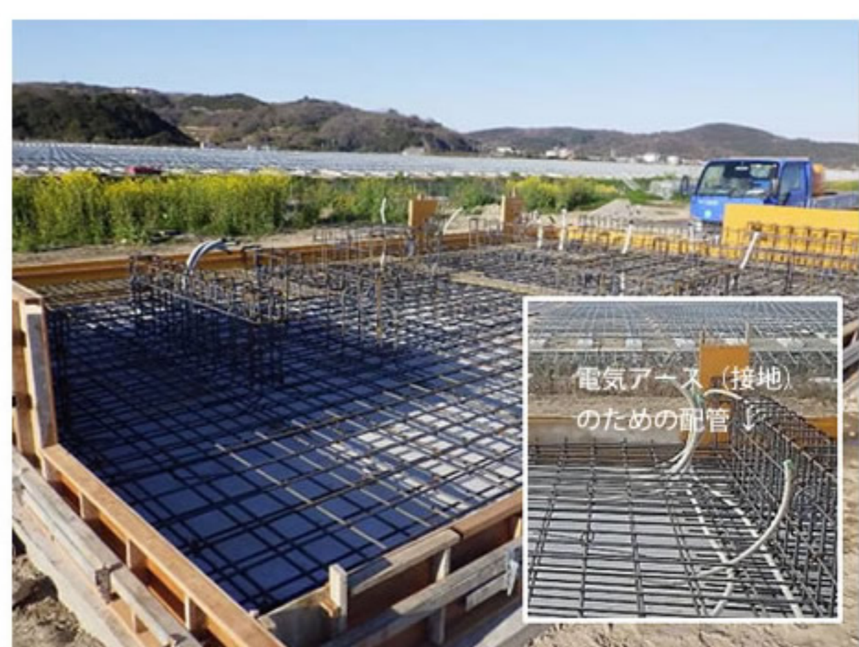
⑧ 鉄筋の周りに型枠を組み立てます
