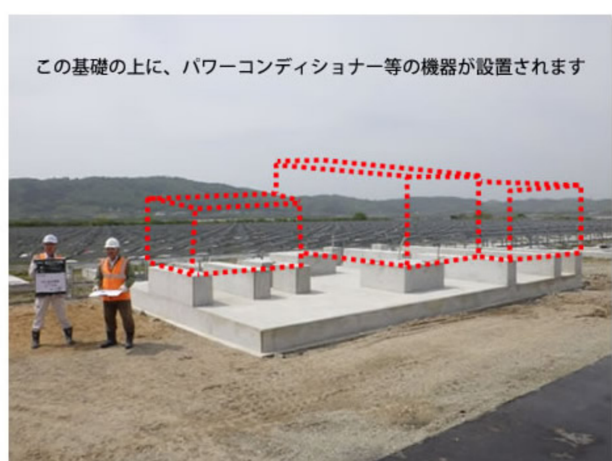
⑫ 型枠を解体して基礎部分の完成です
