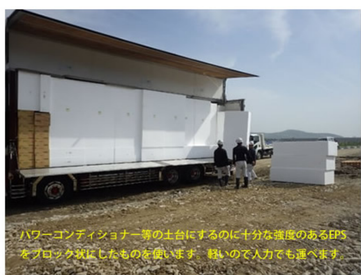
② EPSブロックをトラックで搬入します
