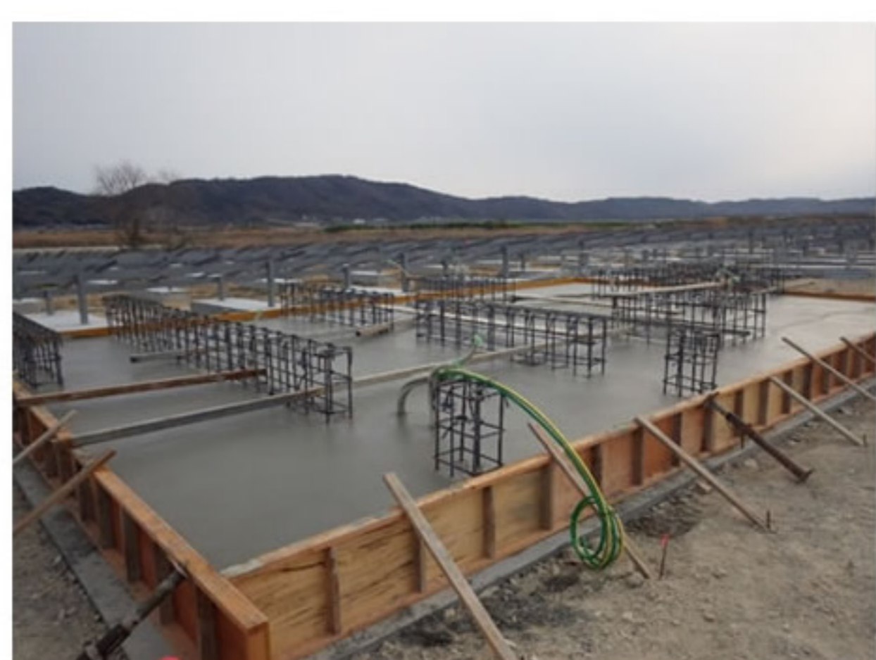
⑩ コンクリートを打設した直後の状況です
