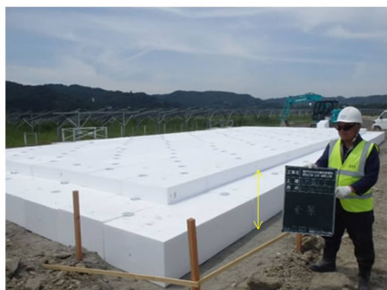
④ EPSブロックの設置を完了しました
