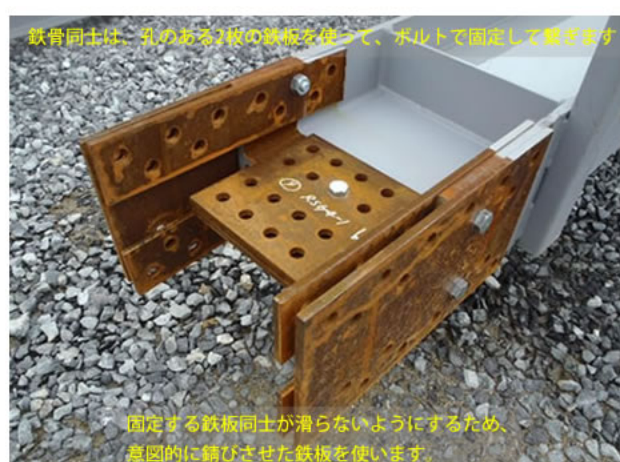
⑤ 鉄骨の接続部分(継手)
