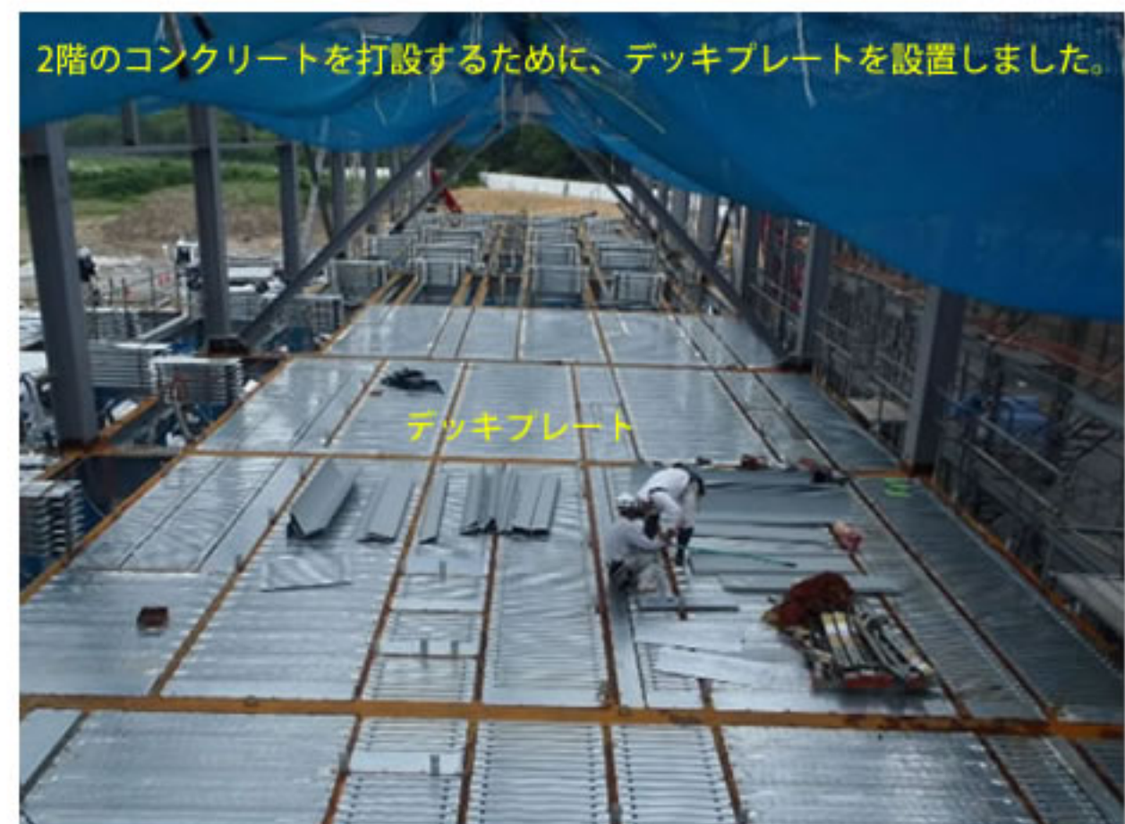
⑩ デッキプレート固定
