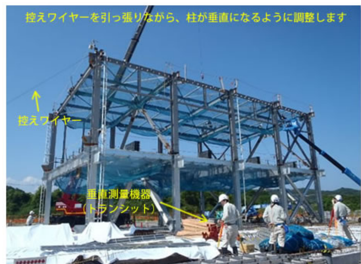
④ 鉄骨の垂直調整
