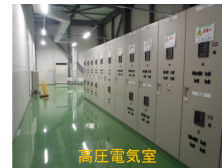
中国電力からの高圧電気を配電する設備です
