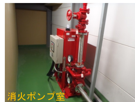
火事の際に使用する消火ポンプが設置されています
