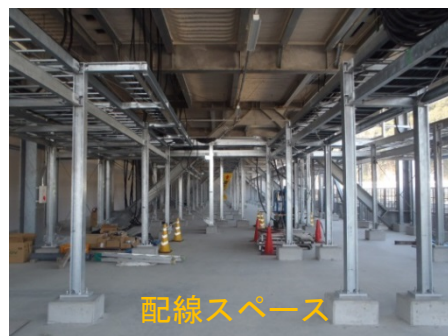
電気ケーブルを乗せる架台が設置されています
