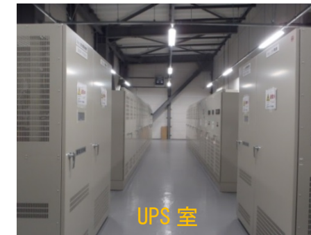
停電時に使用する電力貯蔵装置が設置されています
