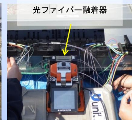
③ ケーブル1本1本の先端を熱で溶かして接続(融着)しています
