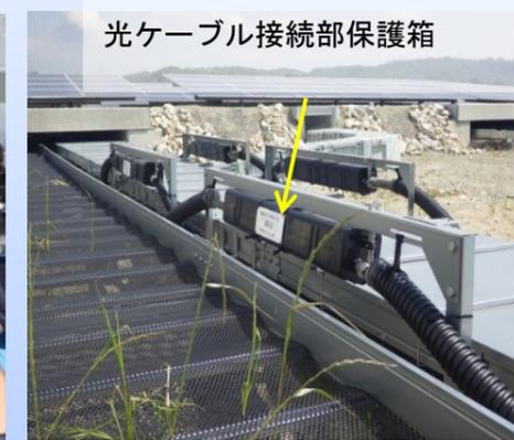
④ 光ケーブルの接続部は、衝撃等による破損を防止するために、箱(クロージャ)で保護されています
