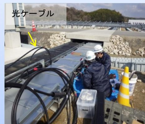
② 光信号を伝送するために光ケーブルを接続している様子
